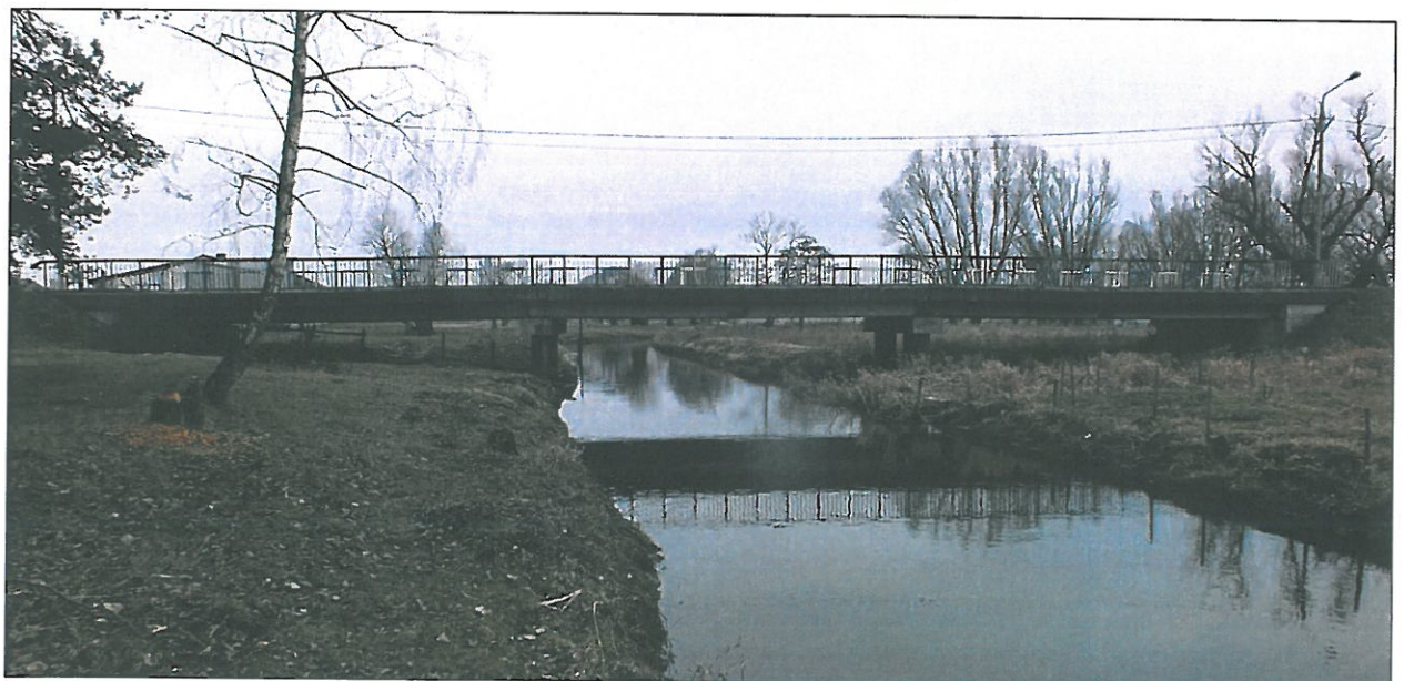
Rys. 1.2 Widok na obiekt od strony wody górnej
