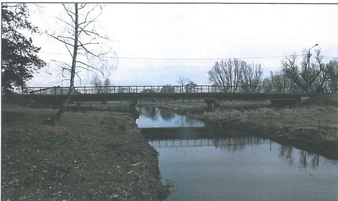
Rys. 2.1 Widok na obiekt od strony wody górnej
