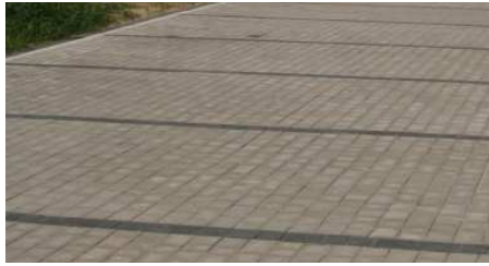
Wyznaczenie liniami miejsc parkingowych
