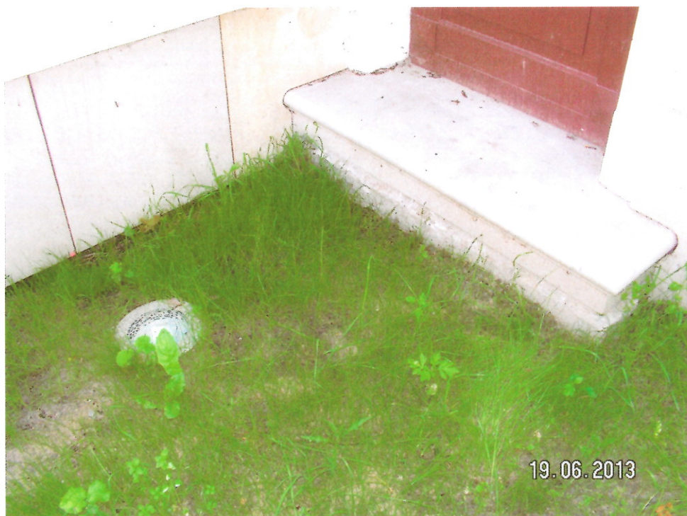
Podest przed wejściem do baszty północnej
