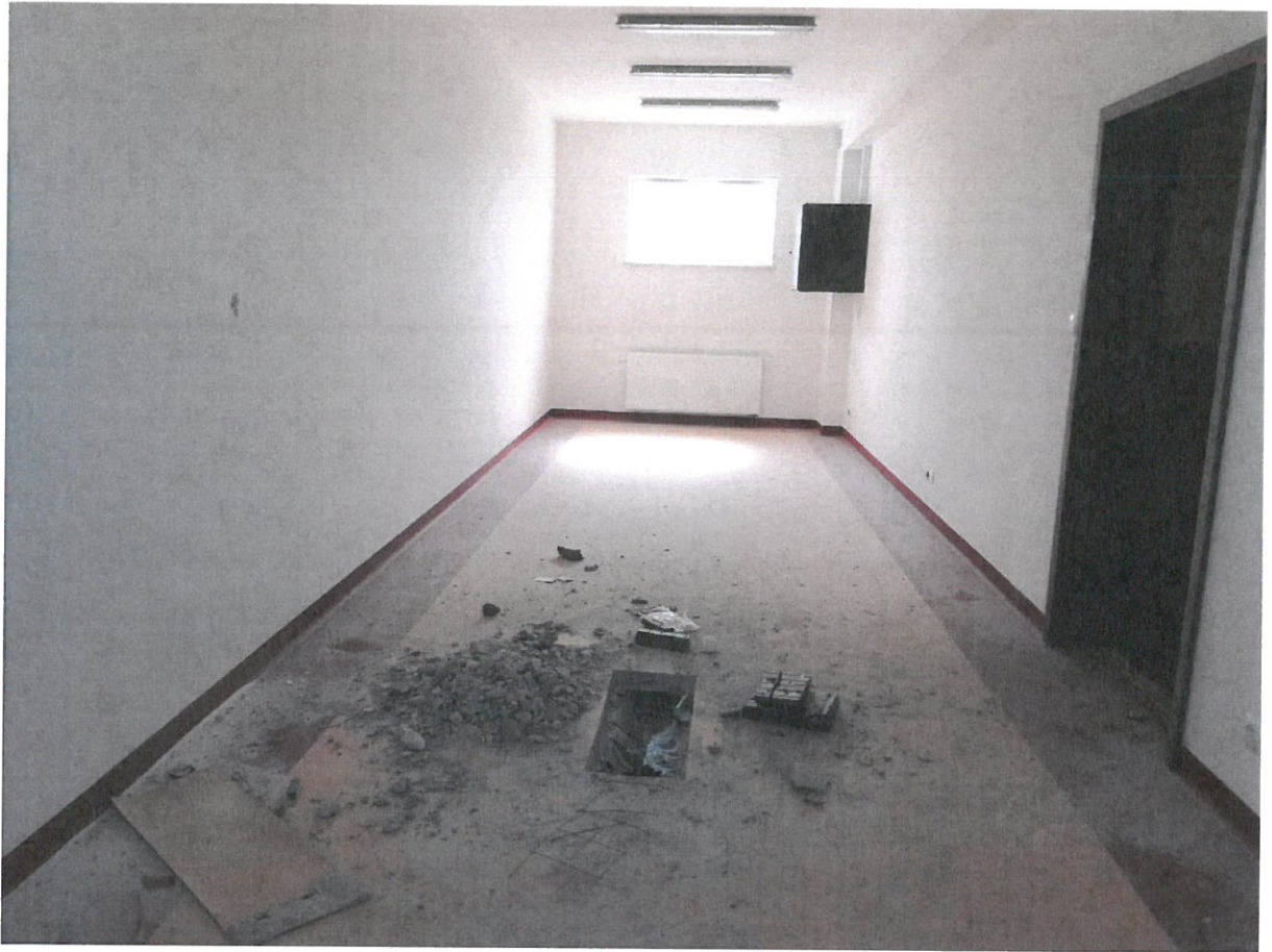
Rys. nr 5 – pomieszczenie na II piętrze
